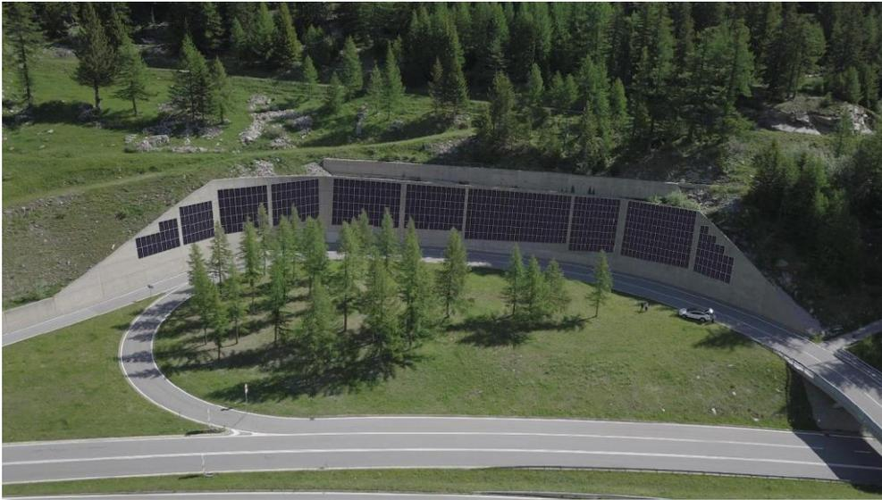
Abbildung 12: Projekt Photovoltaik an der Wand der Ausfahrt nach Simplon
